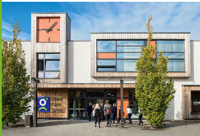
Hlavní budova školy
